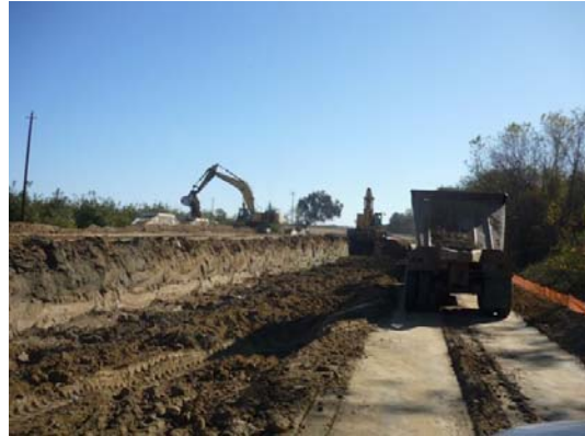
Existing Levee Degrade
