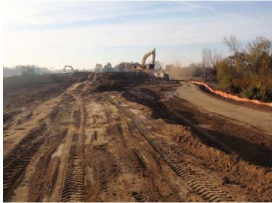
Existing Levee Degrade
